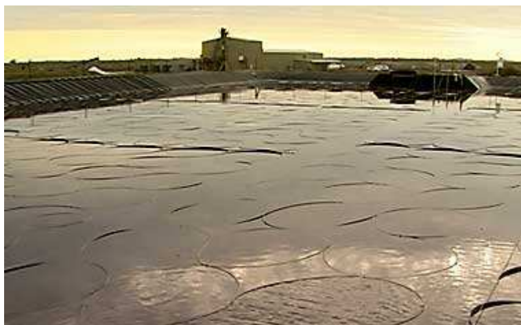
Fig. 1.2 - Barriere galleggianti applicate per ridurre gli effetti del vento sul solar pond di Pyramid Hill, Victoria, Australia
