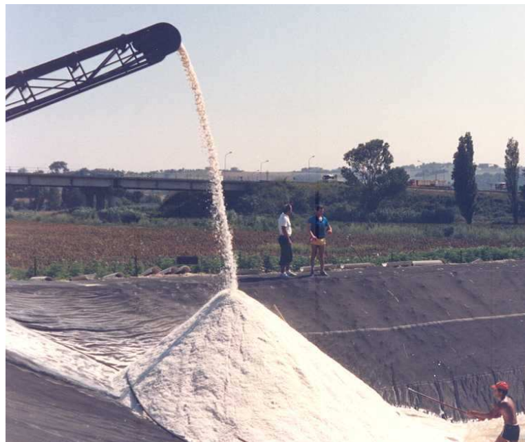
Fig. 4.1 - Fase di riempimento con il sale del solar pond sperimentale di Ancona
